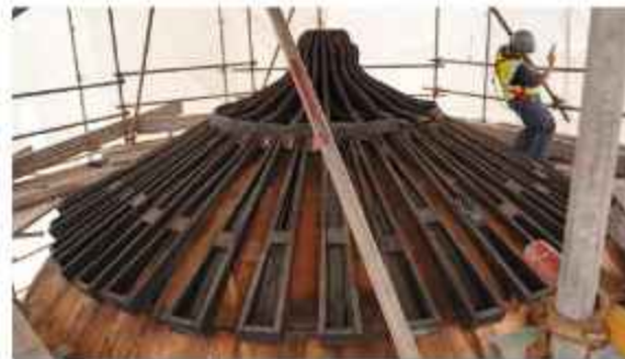
Kerangka kayu bahagian dasar tunjuk langit sebelum ini. The timber base frame of the previous finial.
