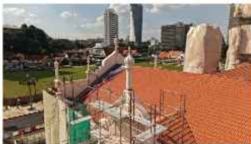
Kerja-kerja pemasangan tunjuk langit sedang dijalankan. Finial installation works in progress.
